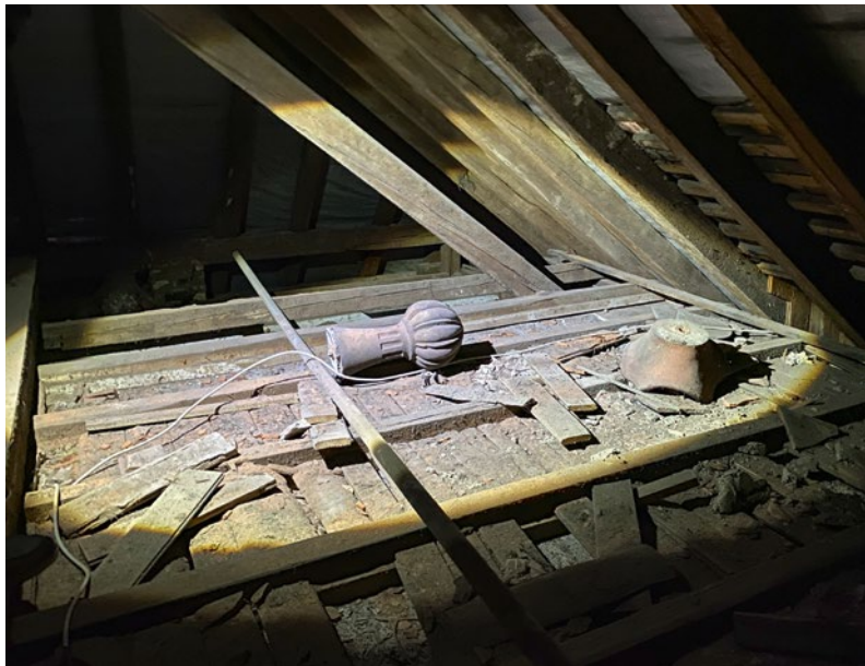
Abb. 8: Versteckt auf einem dunklen Dachboden Eine bauzeitliche Dachspitze aus Baukeramik, rechts daneben die zugehörige Walmkappe, Mai 2021 Foto: H. Zimmermann, LfDH
