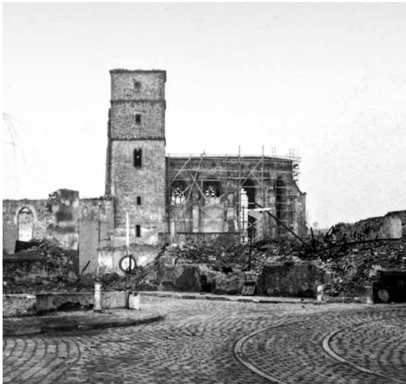
Abb. 2: Ansicht von Süden, 1946 Die Folgen des Bombenkrieges: Verlust aller Dächer, schwere Schäden am Mauerwerk Foto: Archiv LfDH
