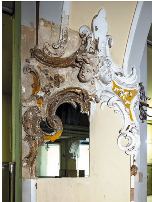
Abb. 3: Musterfläche zur Abnahme der jüngeren Dispersionsanstriche, Zustand 2025
