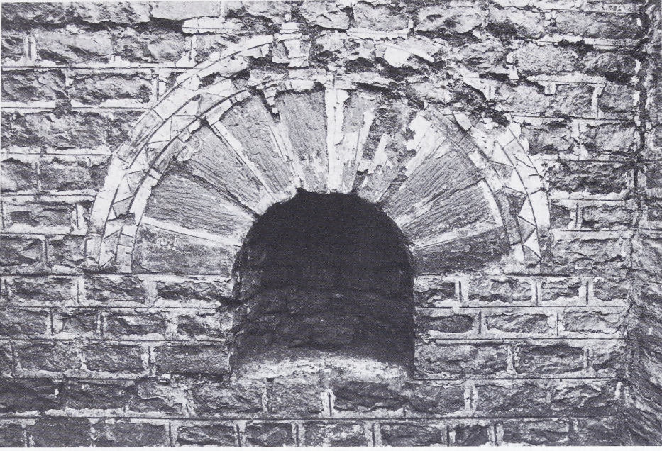
Abb. 53 Bad Wimpfen (Kreis Heilbronn); Fst. 4. Kellernische mit stuckiertem und farblich gefäßigem Keilsteinbogen.
