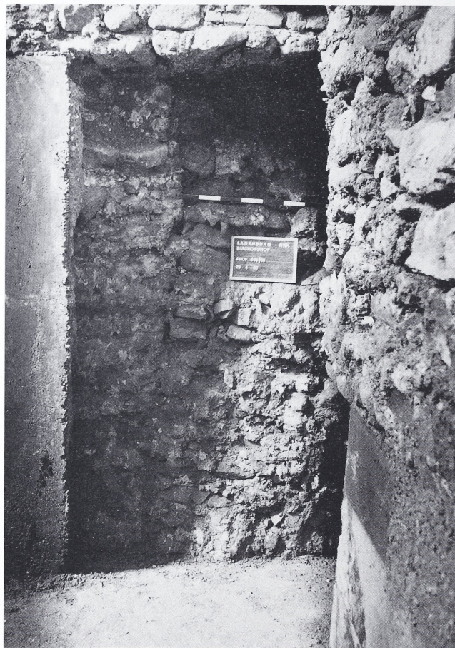
Abb. 92 Ladenburg (Rhein-Neckar-Kreis); Fst. 1. Unterfangung unter der Nordmauer des ursprünglichen südlichen Gebäudes, entsprechend der südlichen Schildmauer des Kellers im Bischofshof.
