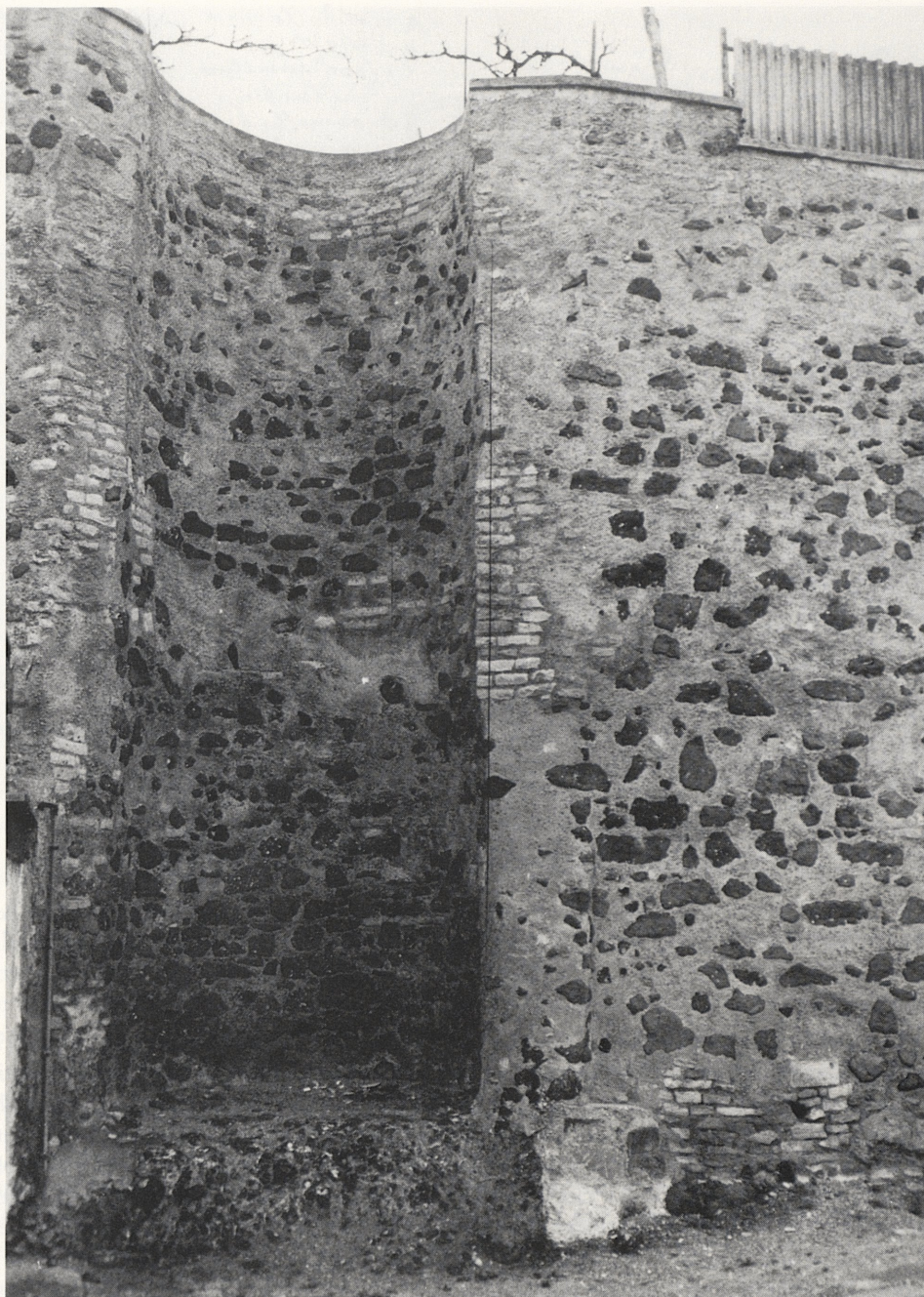
Abb. 25 Erhaltene Halbschale des Schachtes der Zisterne am oberen Langen Weg.
