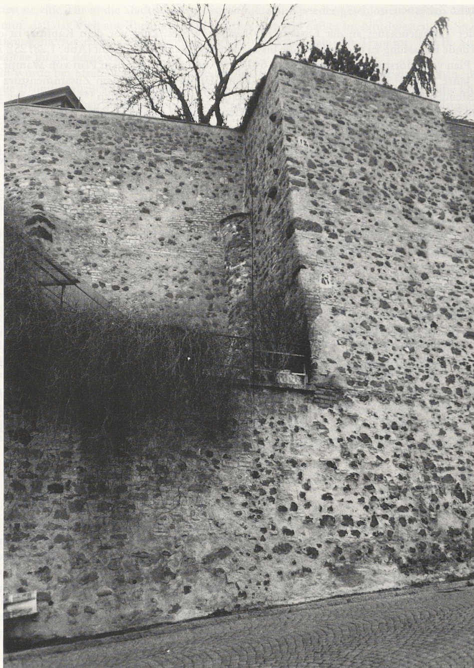
Abb. 26 In der Ecke eines Rücksprunges der Terrassenmauer am Langen Weg erhaltener Rest eines Zisternenschachtes.
