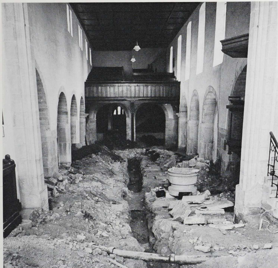
Abb. 8 Hildrizhausen, Kr. Böblingen. St. Nikomedes: Gesamtfoto mit den ausgehobenen Gräben
