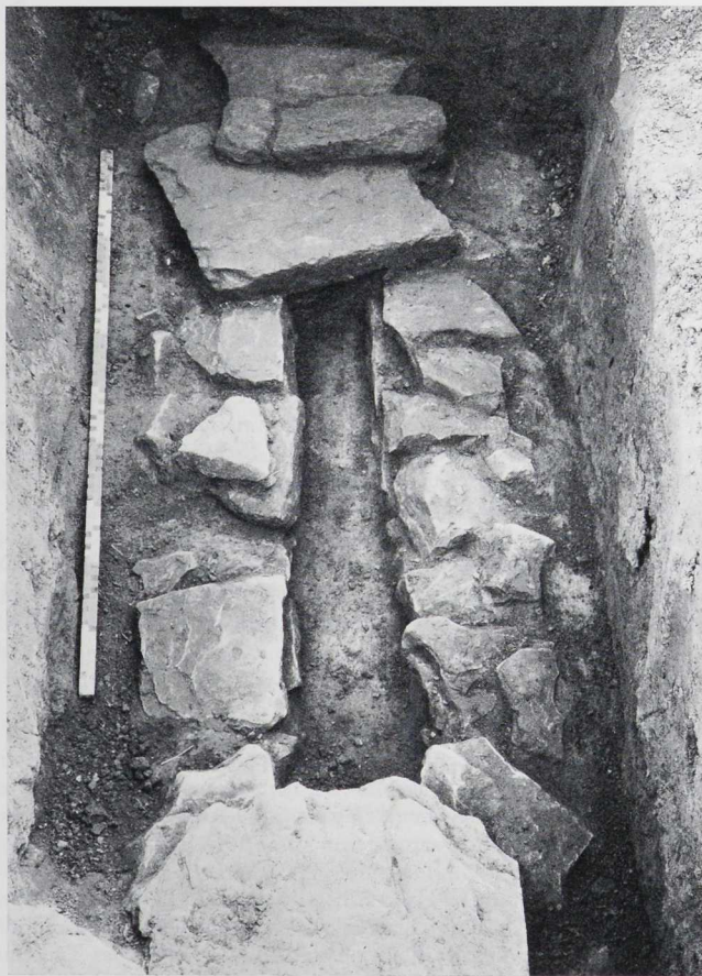
Abb. 124 Schwaigern (Lkr. Heilbronn); Fundstelle 4. Kanal: Seitenwände in Trockenmauerteknik.
