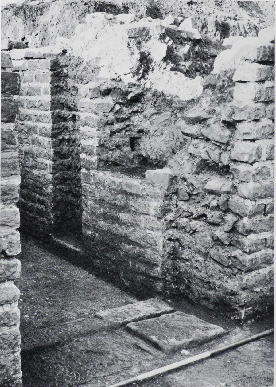
Abb. 116 Rommelshausen (Lkr. Waiblingen). Kellereingang mit Türschwelle.
