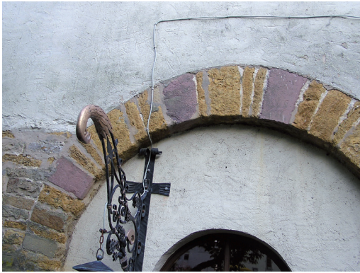
Abb. 1: ‚Blendbogen‘ an der Nordfassade der Sinsheimer Stiftskirche mit der verbauten Inschriftenspolie.
