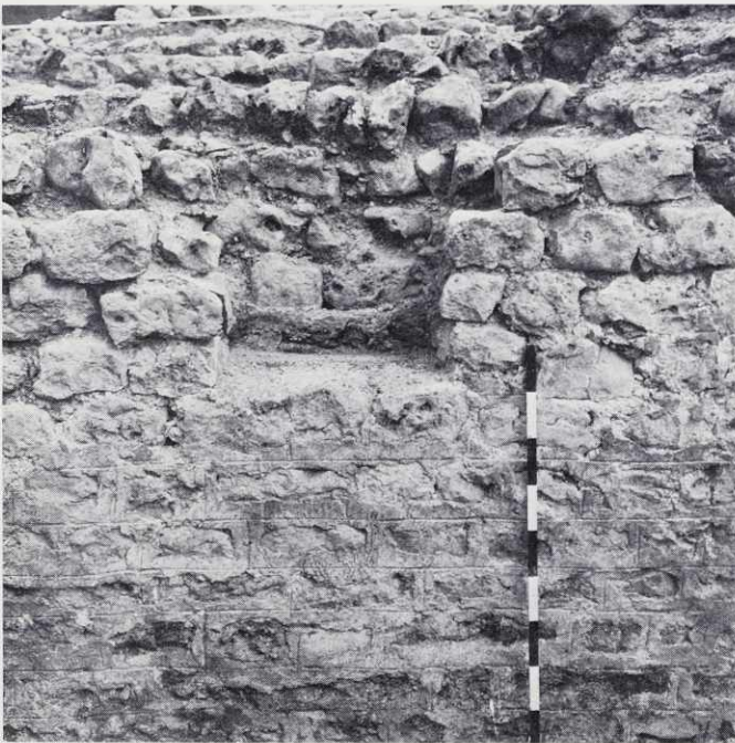
Abb. 152 Oberkochen (Ostalbkreis); Fst. 2. Abstellnische der östlichen Kellerwand.
