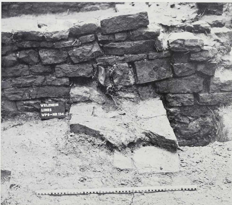
Abb. 189 Welzheim (Rems-Murr-Kreis); Fst. 1. Strebepfeiler zur Sicherung des Fundamentes am Limesturm 9/134.
