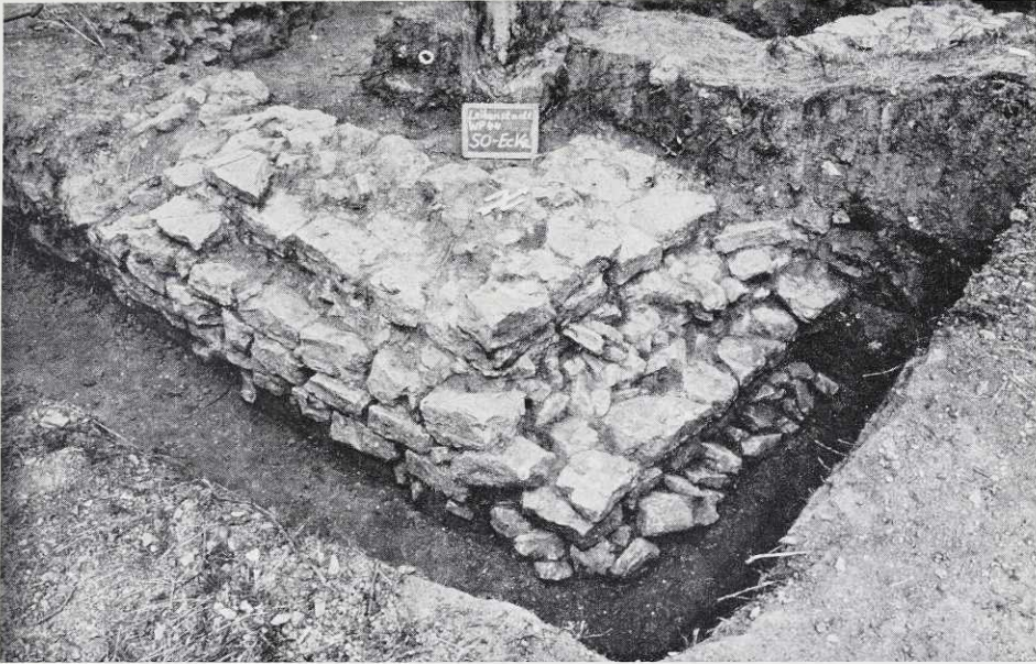
Abb. 174 Schöntal Oberkessach (Hohenlohekreis). Steinfundament der Südostecke des Limesturmes 8/44.
