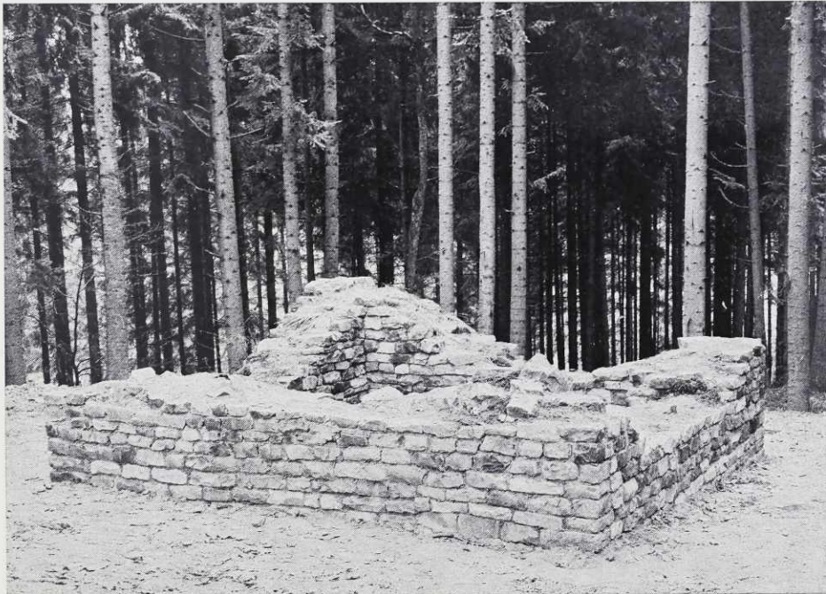
Abb. 188 Welzheim (Rems-Murr-Kreis); Fst. 1. Fragmente des Limeswachturmes 9/134, deutlich zu sehen die zweischalige Mauertechnik.
