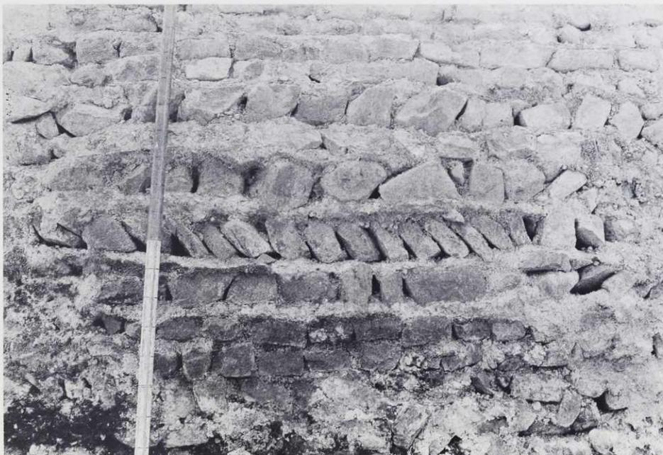
Abb. 14 Burgus Ladenburg. Mauertechnik im Fundament der Nordmauer des Mittelturmes. Ansicht von Norden.
