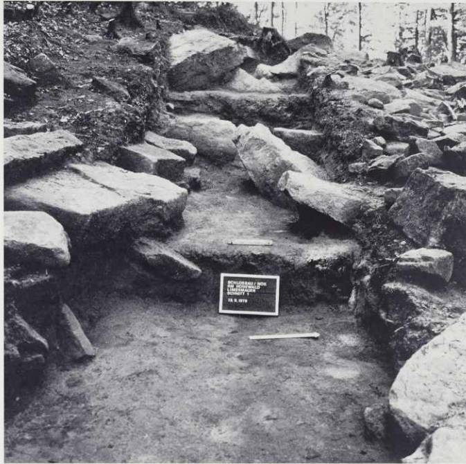
Abb. 3 Mudau-Schloßau, Limesmauer „Am Hohewald“. Schnitt 1; Blick in den Westteil des Schnittes mit anstehendem Fels.
