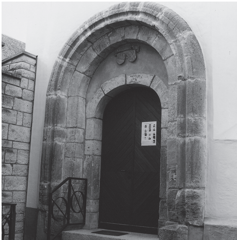
Abb. 26 Starzach-Wachendorf, Kirche SS Peter & Paul. Romanisches Rundbogenportal an der Südwestecke des Langhauses, bis 1877 an der Westseite der Kirche, von Südosten (Aufnahme: LDA Baden-Württemberg).
