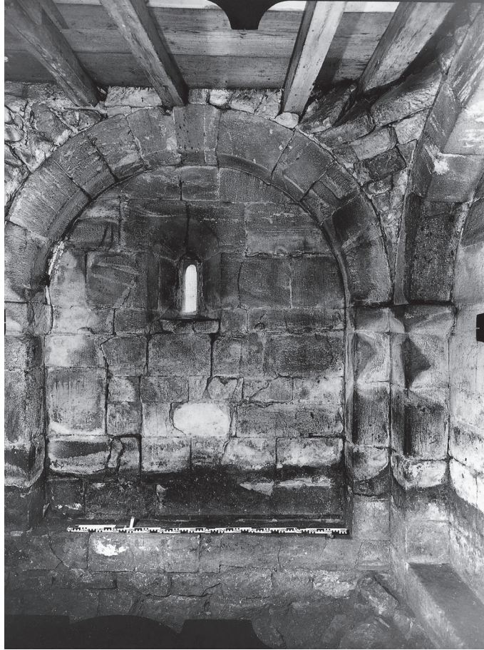
Abb. 25 Starzach-Wachendorf, Kirche SS Peter & Paul. Untergeschoss des Turmes. Fensternische in der Westwand mit Ansätzen des Kreuzgewölbes, von Osten (Aufnahme: LDA Baden-Württemberg).
