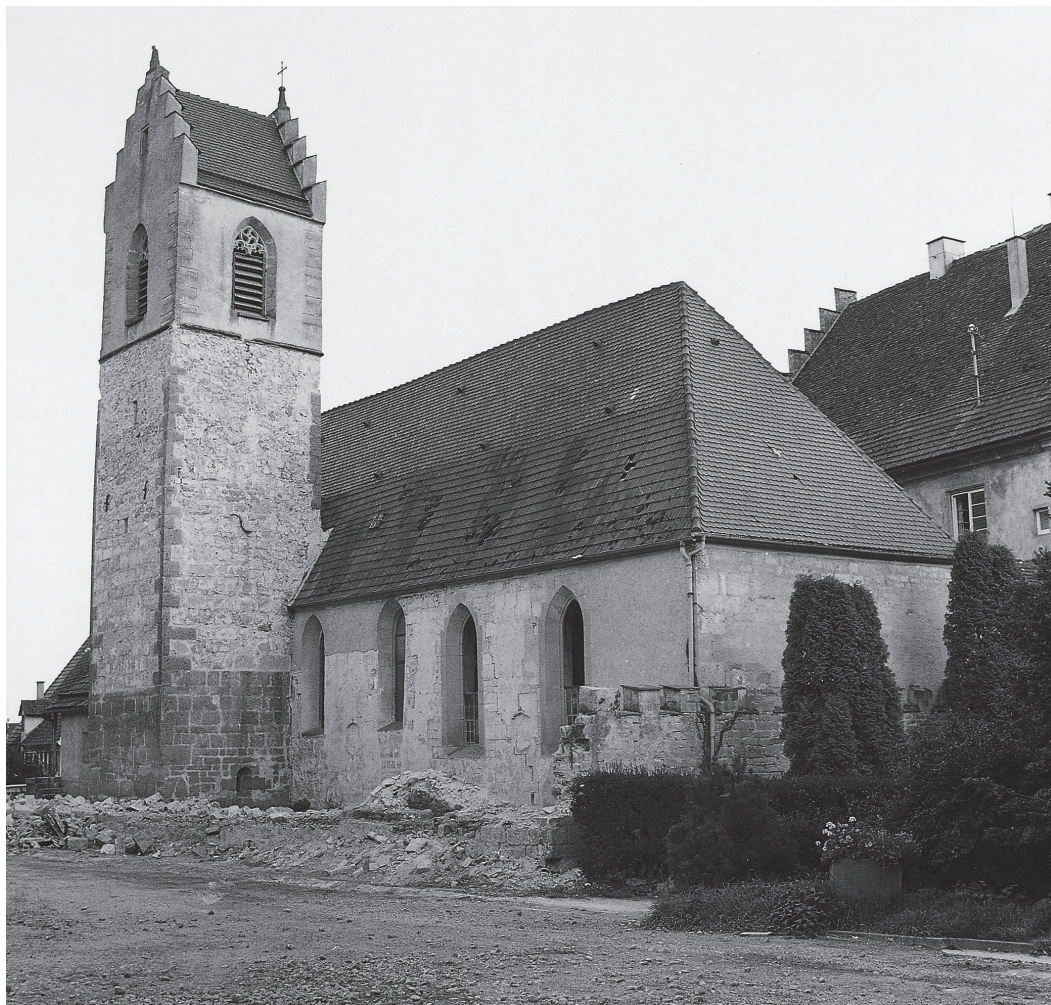
Abb. 35 Starzach-Wachendorf, Kirche SS Peter & Paul. Ansicht der Kirche von Norden. Deutlich sind die beiden größeren Fenster der Langhauserweiterung von 1877 zu erkennen, von Nordwesten. Zustand 1977 (Aufnahme: LDA Baden-Württemberg).
