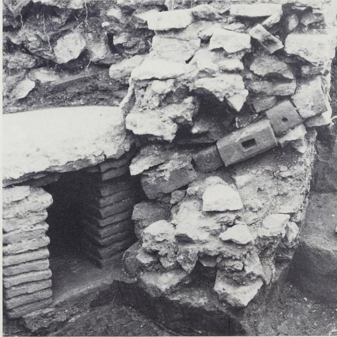
Abb. 115 Mundelsheim (Kreis Ludwigsburg); Fst. 2. Detail der Hypokaustanlage in Raum II.
