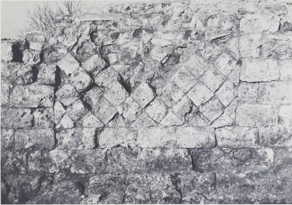
Abb. 142 Rainau Dalkingen (Ostalbkreis); Fst. 1. Detailansicht der Südfront.
