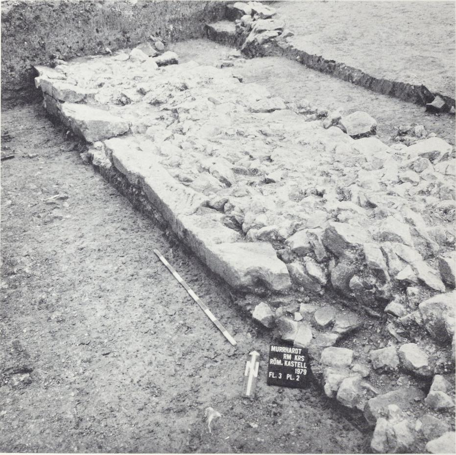
Abb. 10 Murrhardt, Grabung 1979. Kastellmauer mit aufgehendem Mauerwerk aus Schilfsandsteinen und einem 4 m langen Mauervorsprung von 0,1 m.
