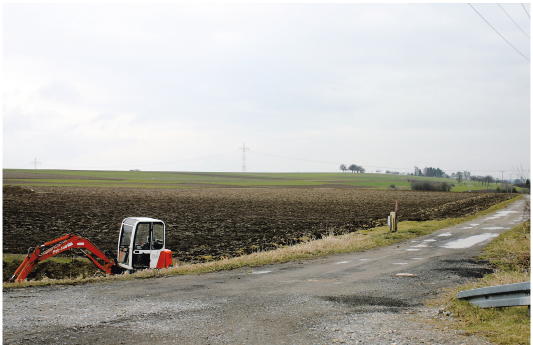
Abb. 7: Rohrdorf. Das Grabungsareal von Westen. In Bildmitte das Gelände des Annexbaus mit der Götterhalle (Foto Verf. 2009).
