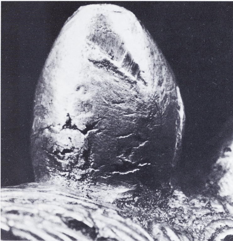
Abb. 10 Risse in der Rückseite des linken Ohres.
