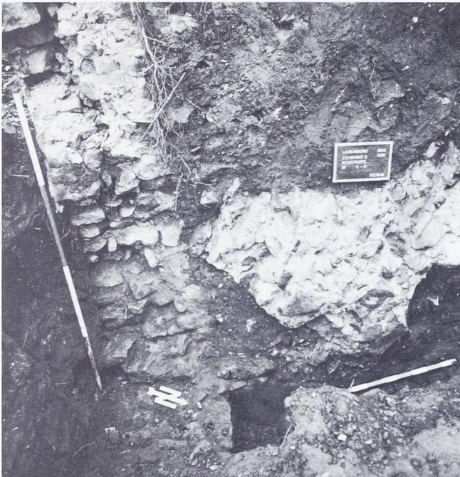
Abb. 129 Ladenburg (Rhein-Neckar-Kreis); Fst. 4. Links die Zwingermauer, rechts ein herabgestürztes Stück der weiter rechts liegenden, wegen der geringen Tiefe der Fundamentgräben nicht beobachteten Stadtmauer.
