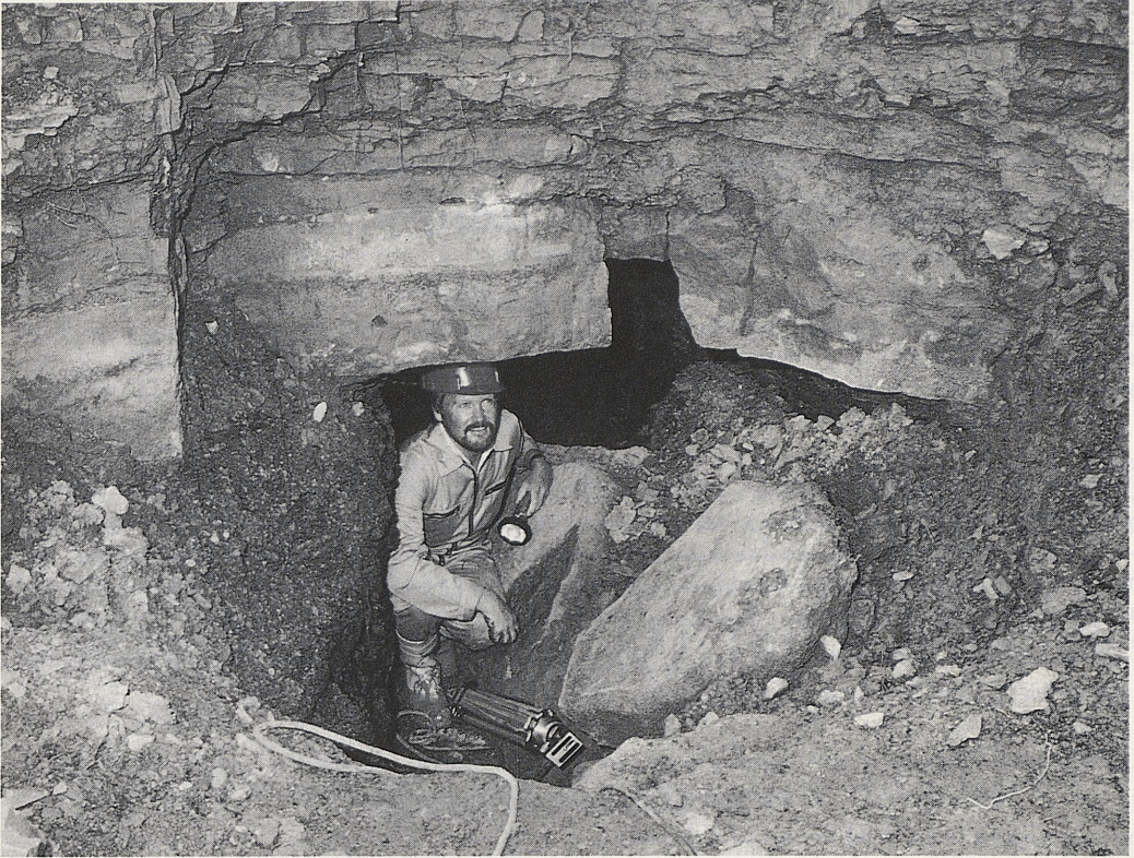
Abb. 1 Bei Bahnbauarbeiten aufgewältigter Einstieg in die alte Kohlengrube (=Punkt B im Grundriß, vgl. Abb. 2). Die Stollenfirste (Decke) bildet die harte Anthrakonitbank.
