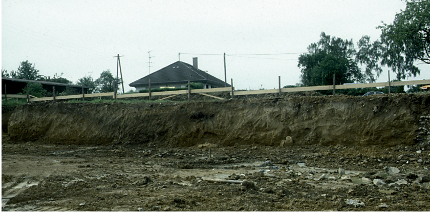
Abb. 8: Gartenstraße 1991. Situationsfoto der nördlichen Baugrubenkante im Bereich der Profile 1 und 2.
