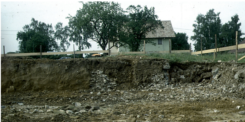
Abb. 9: Gartenstraße 1991. Situationsfoto der nördlichen Baugrubenkante im Bereich der Profile 1 und 3.
