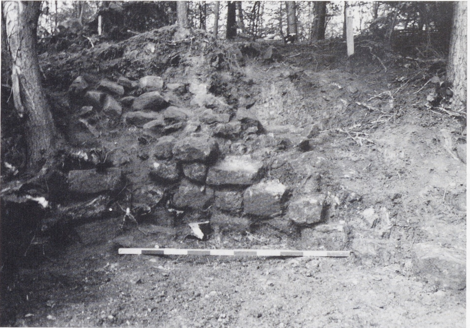
Abb. 43 Baden-Baden Ebersteinburg. Reste einer römischen Mauer in Zweischalentechnik.
