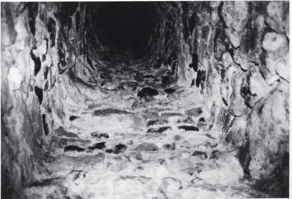
Abb. 14 Gemauerter Lüftungsschacht der Kasematten im Eckartsberg (Foto: LDA).
