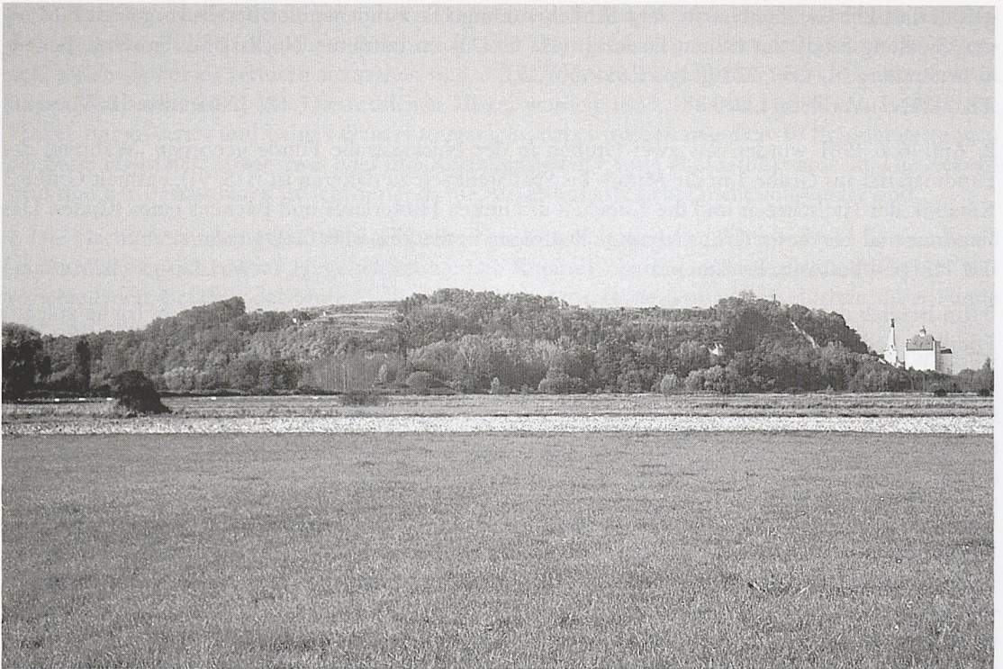
Abb. 28 Riegel (Lkr. Emmendingen). Ansicht des Michealsberges von Osten (Fotoarchiv LDA Baden-Württemberg, Abt. I, Außenstelle Freiburg).
