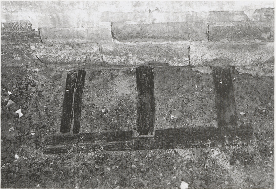
Abb. 125 Emmendingen. Balkenrost im Mühlbach (Foto: H. Zehner).
