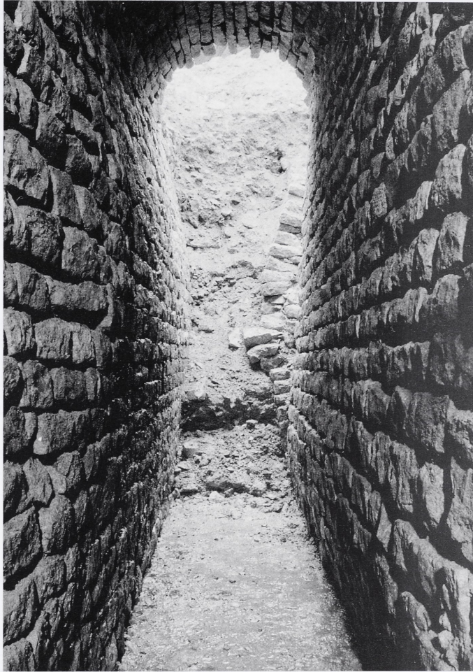
Abb. 2 Badenweiler. Römische Heilthermen. Blick von Norden durch den restaurierten Teil des östlichen Drainagekanals auf den noch verstärzten und verfüllten Kanalteil mit den 30–50 cm mächtigen, basalen Feuchtsedimenten.
