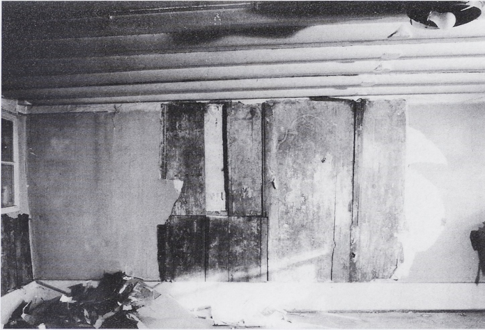
Abb. 12 Konstanz, Wessenbergstr. 12. Straßenseitige Stube im ersten Stock (Süd), Blick auf die Südwand mit ornamental bemalter Täferung. Foto: LDA.
