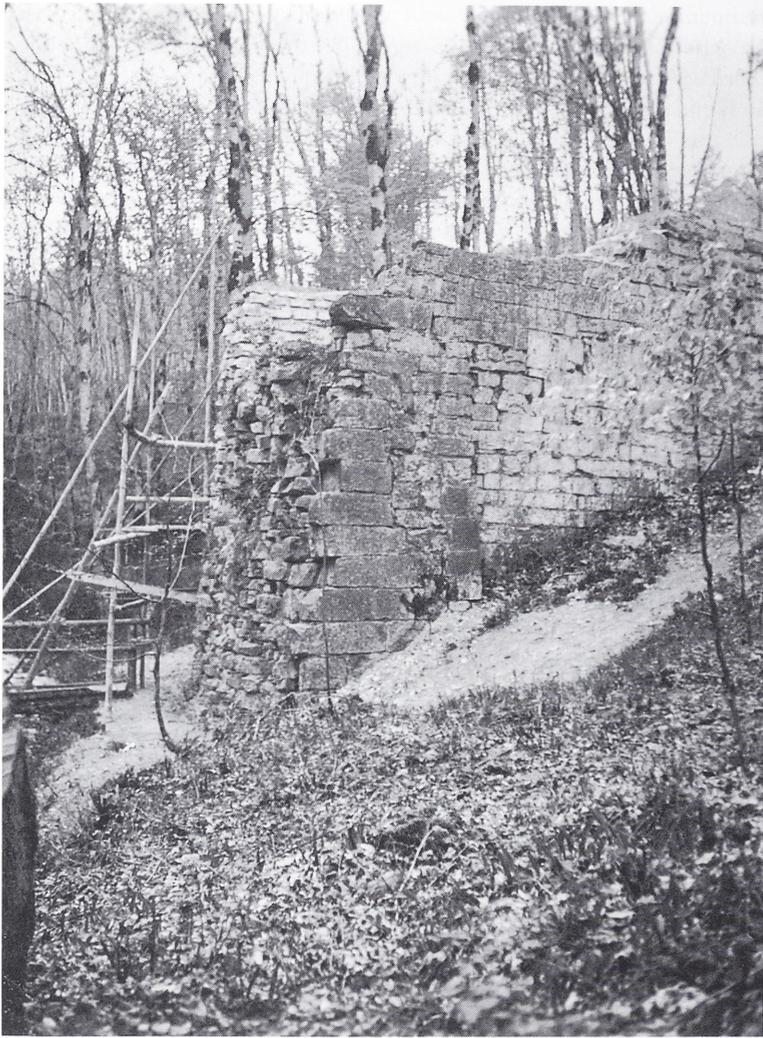
Abb. 5 Jestetten. Brückenuine über den Volkenbach. Foto der Restaurierungsarbeiten von 1938. Die bereits 1893 neu aufgemauerten Strebpfeiler heben sich mit ihrem dunklen Steinmaterial deutlich vom helleren Originalmauerwerk ab.
