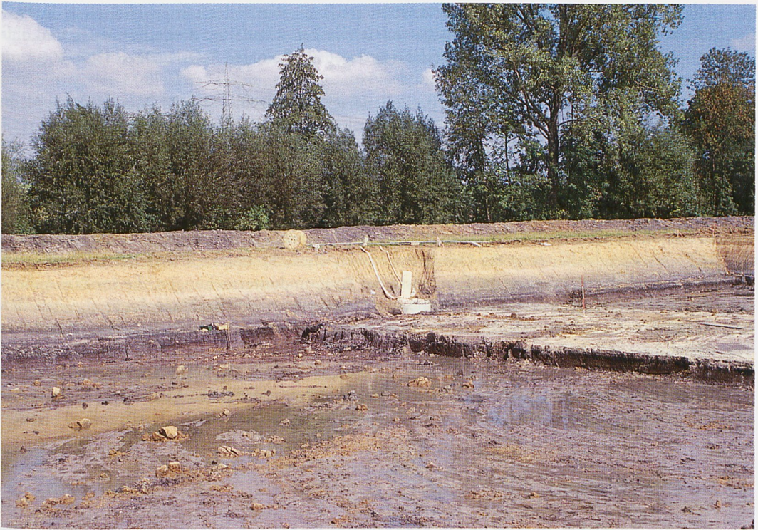
Abb. 3 Die Baugrube für das Regenwasserbehandlungsbecken im Leinbachtal bei Großgartach am 21. September 1998. Über der braunen Torfschicht erkennt man Seekreide (rechts im Bild), darüber schwarzgrauen Auenlehm, der von ockerfarbenem Auenlehm überlagert wird.
