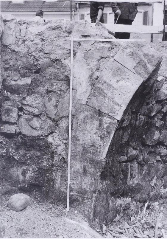
Abb. 5 Nördlicher Bogenansatz der Apsis mit typischer Steinbearbeitung der 2. Hälfte des 12. Jahrhunderts.
