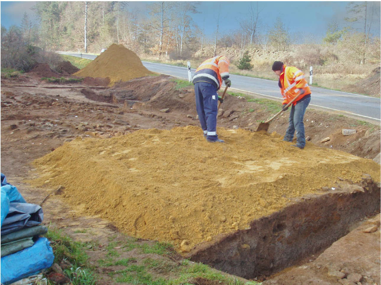
Abb. 19. Weiltingen (Lkr. Ansbach). Überdeckung der Limesmauer nach der Dokumentation (Foto: B. Pargmann, BLFD).
