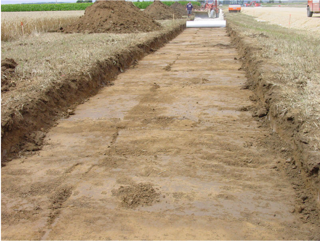
Abb. 28. Konservatorische Überdeckung auf dem Oberboden im Bereich der Bundesstraße 25 Nordumfahrung Nördlingen (Lkr. Donau-Ries); im Bereich des Radweges wurde das Geovlies nach dem Bodenabtrag verlegt (Foto: St. Berg, BLfD).
