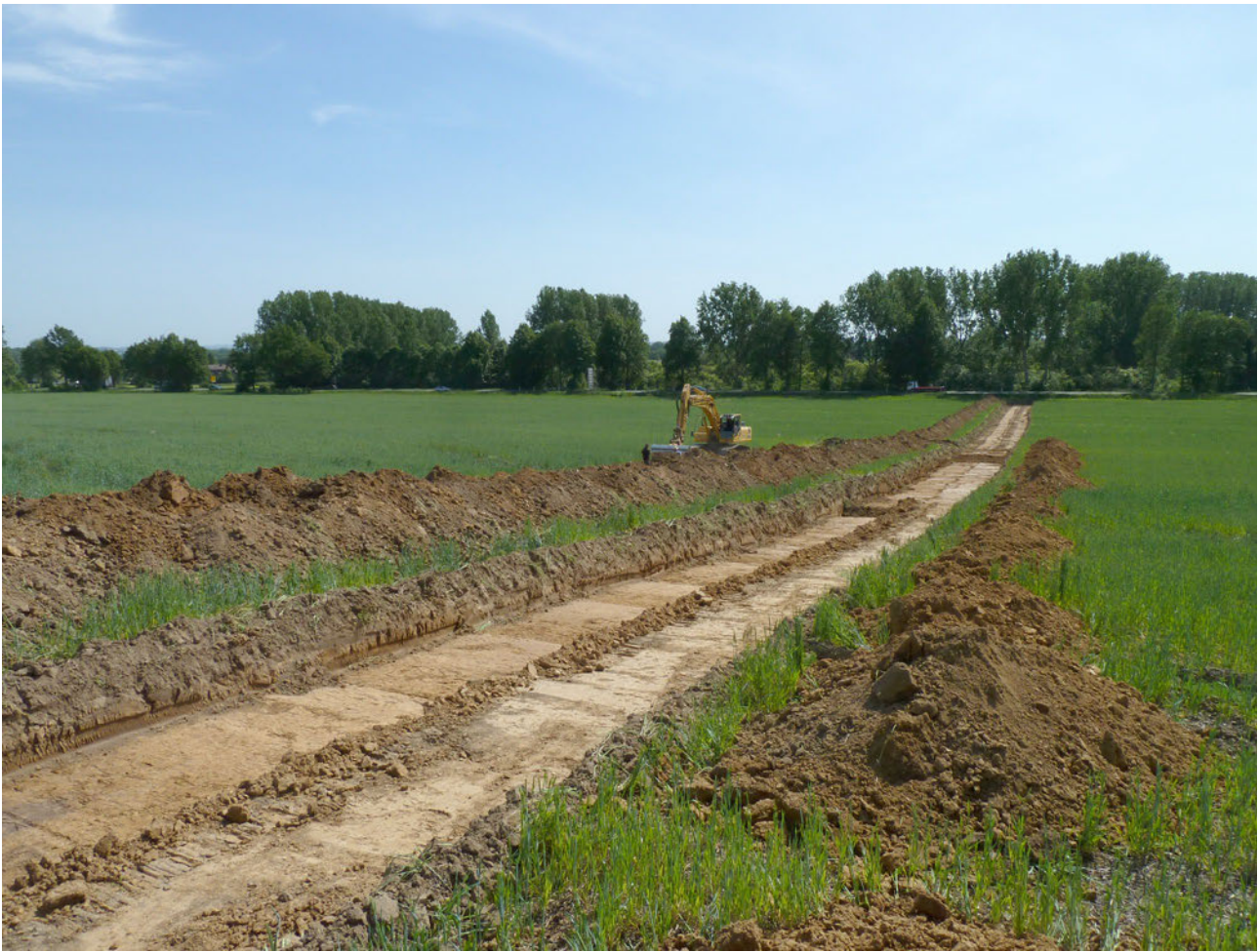
Abb. 43. Bergkamen-Oberaden (Kr. Unna). Im oberen Teil des Geländes wurden merowingerzeitliche Gräber ausgegraben; hangabwärts sind sie durch ein Kolluvium geschützt (Foto: LWL-Archäologie für Westfalen).
