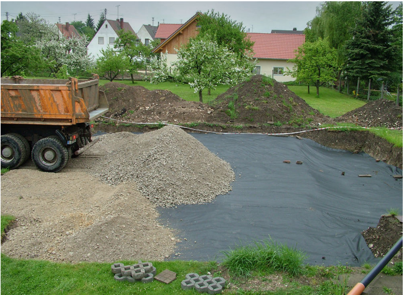
Abb. 26. Kösching (Lkr. Eichstätt). Ein Geovlies wurde verlegt, nachdem der Humus maschinell entfernt worden war. Auf dem Vlies wurde der Schotter verteilt (Foto: Bildarchiv, BLfD).
