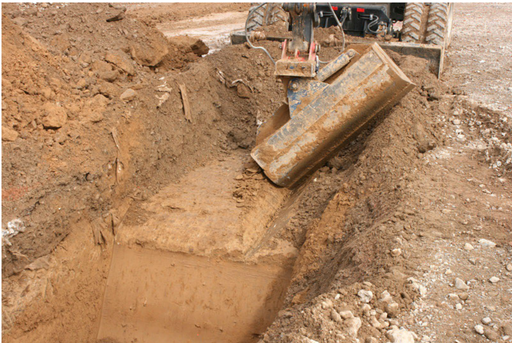
Abb. 24. Estenfeld (Lkr. Würzburg). Der unter dem Schutzvlies stark verdichtete Löss, in dem sich Befunde befanden, konnte aufgrund der extremen Verdichtung händisch nicht bearbeitet werden. Das maschinelle Lockern erfolgte durch das Aufritzen mit dem Böschungslöffel (Foto: U. Müller, Fa. Büro für archäologische Ausgrabung und Dokumentation Heyse).
