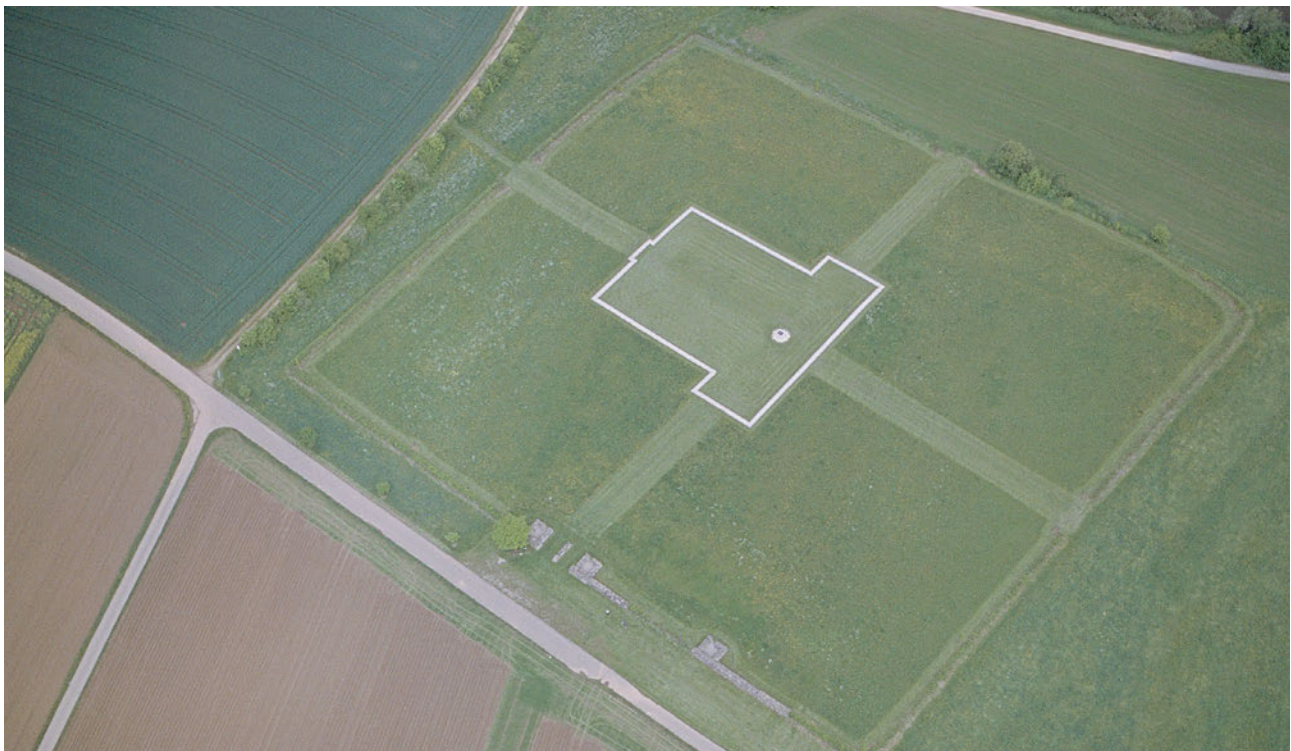
Abb. 14. Rainau-Buch (Ostalbkreis). Blick auf das Kastellareal mit überdeckten Mauern (© Landesamt für Denkmalpflege im Regierungspräsidium Stuttgart / Foto: Otto Braasch, L7126-005-02_3687-0).
