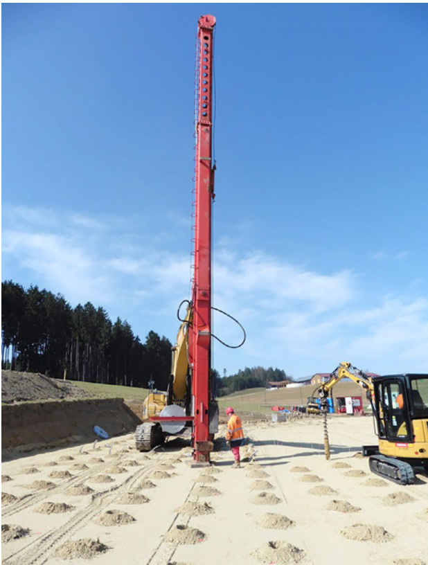
Abb. 20. Essenbach (Lkr. Landshut). Verschiedene Schritte einer Bändchendrainage im Bereich der B15 neu (Foto: A. Appelt, Autobahndirektion Südbayern).
