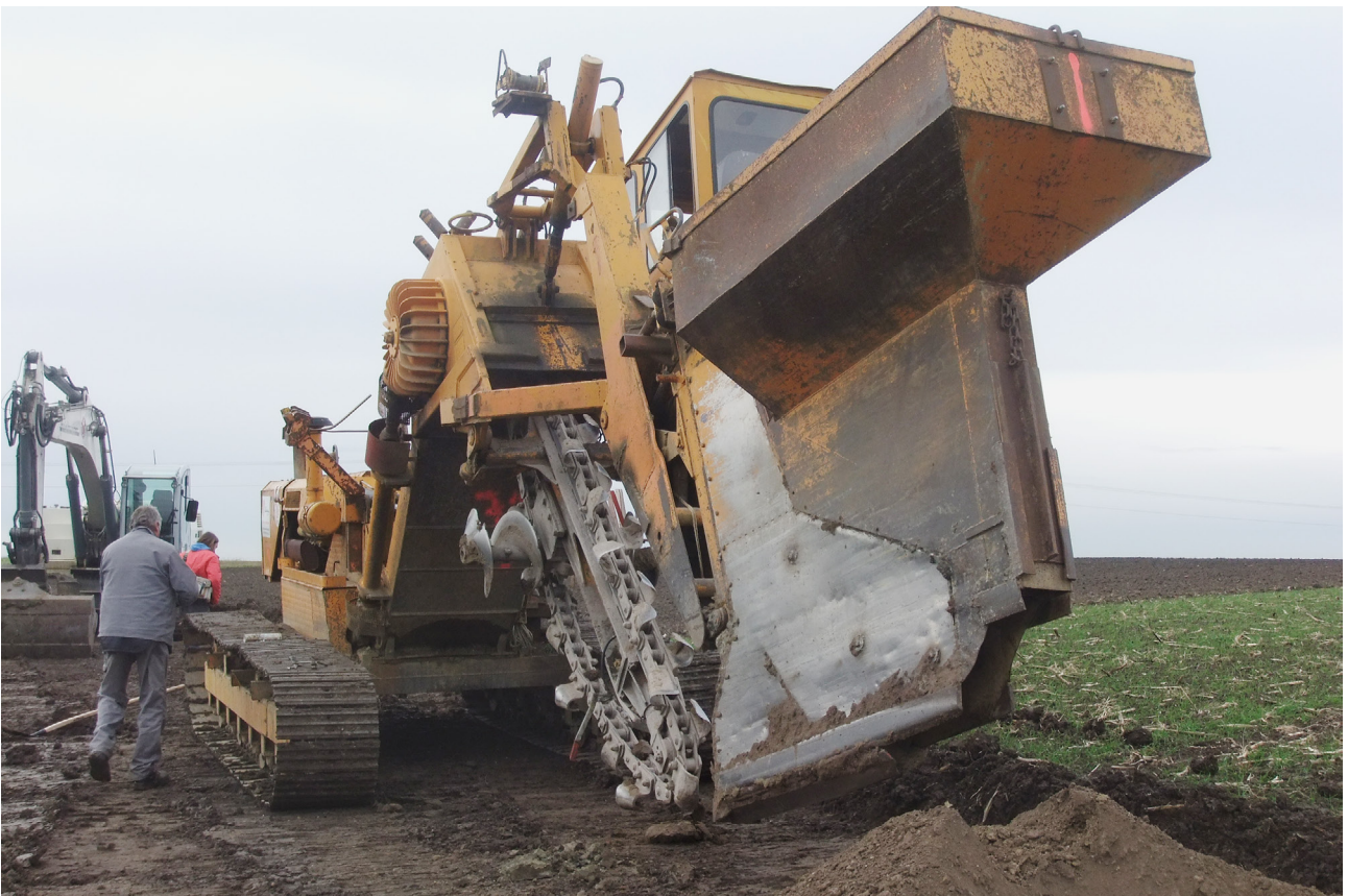
Abb. 3. Ein Kabelpflug (Foto: M. Nadler, BLfD).
