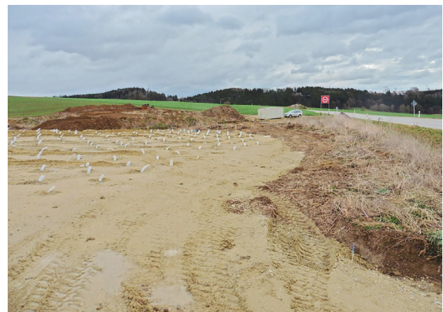
Abb. 22. Essenbach (Lkr. Landshut). Bändchendrainage im Bereich der B15 neu (Foto: A. Appelt, Autobahndirektion Südbayern).
