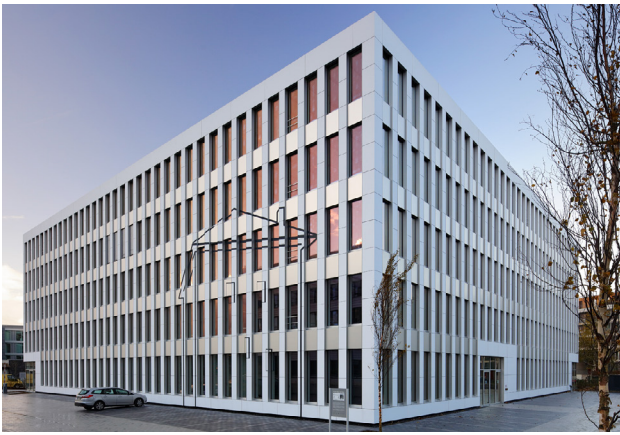
Abb. 36. Essen. Neubau Geschäftshaus „Silberkuhlsturm“. Neubau mit Silhouette des historischen Bauwerks (Foto: LVR-ABR).
