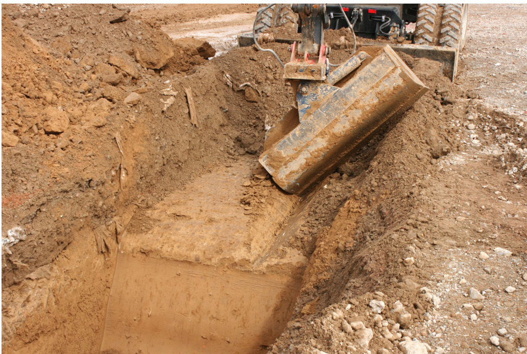
Abb. 24. Estenfeld (Lkr. Würzburg). Der unter dem Schutzvlies stark verdichtete Löss, in dem sich Befunde befanden, konnte aufgrund der extremen Verdichtung händisch nicht bearbeitet werden. Das maschinelle Lockern erfolgte durch das Aufritzen mit dem Böschungslöffel (Foto: U. Müller, Fa. Büro für archäologische Ausgrabung und Dokumentation Heyse).
