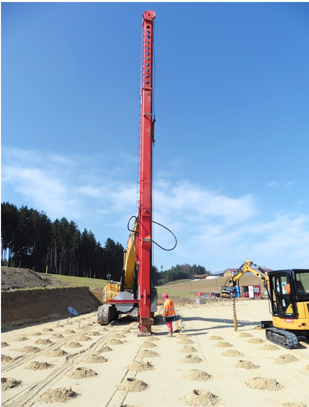
Abb. 20. Essenbach (Lkr. Landshut). Verschiedene Schritte einer Bändchendrainage im Bereich der B15 neu (Foto: A. Appelt, Autobahndirektion Südbayern).
