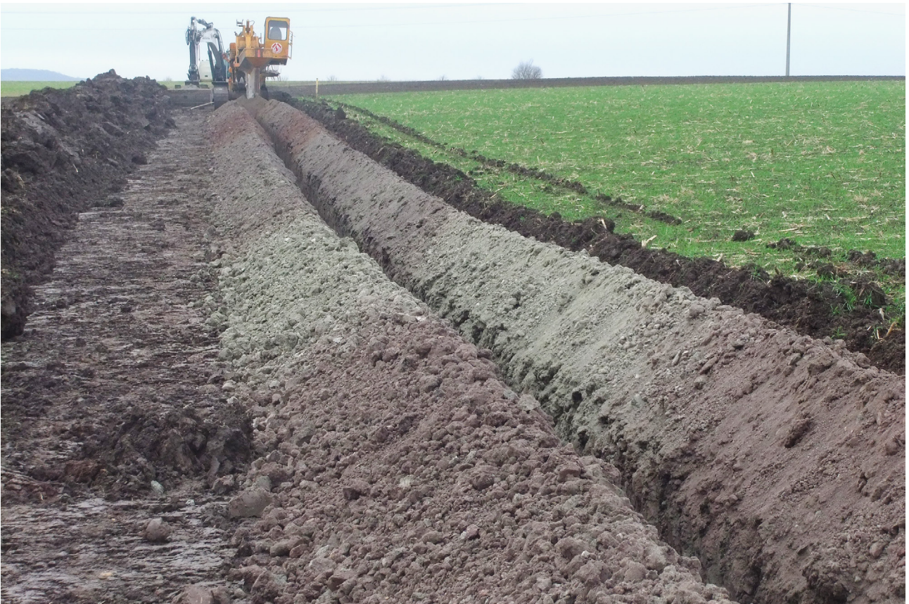
Abb. 2. Für das Verlegen dieser Wasserleitung in Mittelfranken mithilfe eines Kabelpflugs ist ein Humusabtrag erforderlich. Auch bei dieser Methode kann eine bodendenkmalpflegerische Maßnahme erforderlich werden (Foto: M. Nadler, BLfD).
