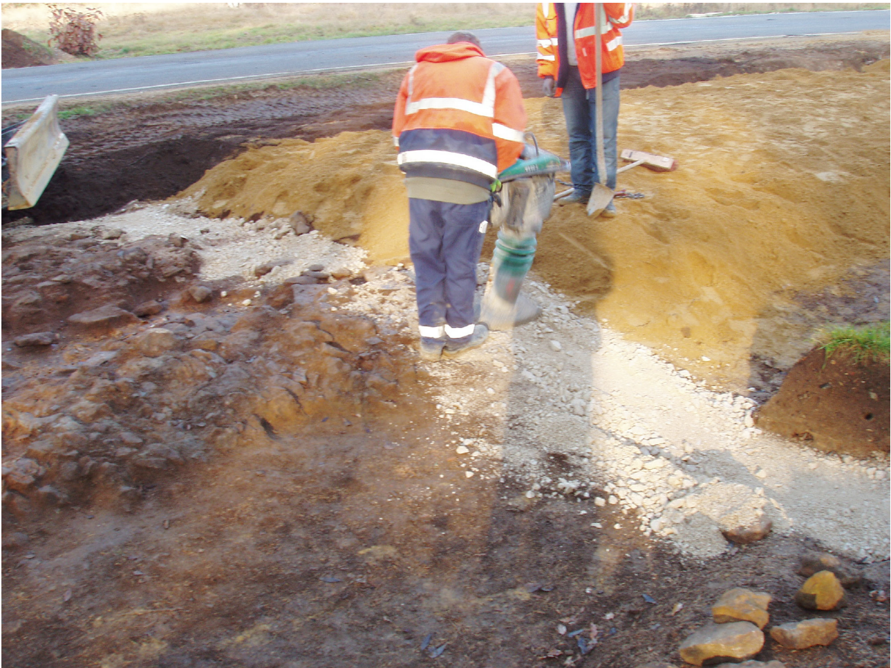
Abb. 18. Weiltingen (Lkr. Ansbach). Überdeckung der Limesmauer nach der Dokumentation (Foto: B. Pargmann, BLfD).
