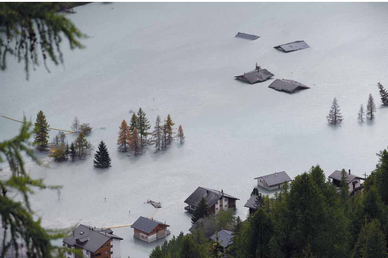
Abb. unten: Talaufwärts wird der gletschergespeiste Fluss Lonza durch die Schuttmasse gestaut, wodurch die nicht vom Bergsturz verschütteten Häuser des Dorfes im Wasser versinken (Foto: September 2025).
