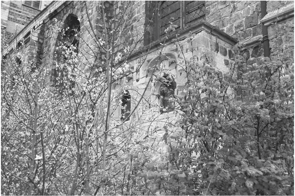
Figure 4: Vue extérieure de la chapelle funéraire d'Hervé de Mériadec et de Jeanne de Croix. L'enfeu n'est pas encastré dans le mur de l'église, mais est en saillie. Les deux fenêtres (murées depuis) sont enrichies d'un encadrement trilobé. Il paraît peu probable que le toit ait toujours été plat: les combles pointus que l'on attend peuvent avoir disparus en même temps que l'arcature intérieure du monument. Si effectivement les vitraux ( infra , fig. 14) sont antérieurs à la fondation d'Hervé de Mériadec, le gros œuvre de la chapelle doit l'être aussi, sauf déplacement des vitraux ou fondation rétrospective (Cliché Sébastien Hamel/Franck Viltart, 23 mars 2007).
