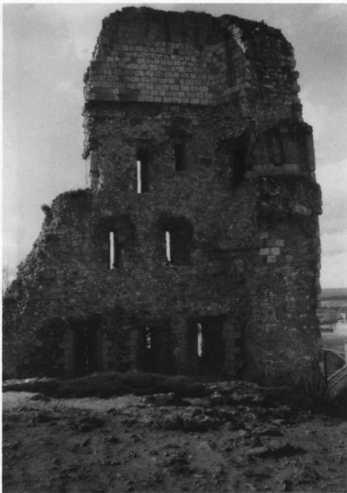
Figure 13: latrines, flanc ouest du château, construit après 1205.
