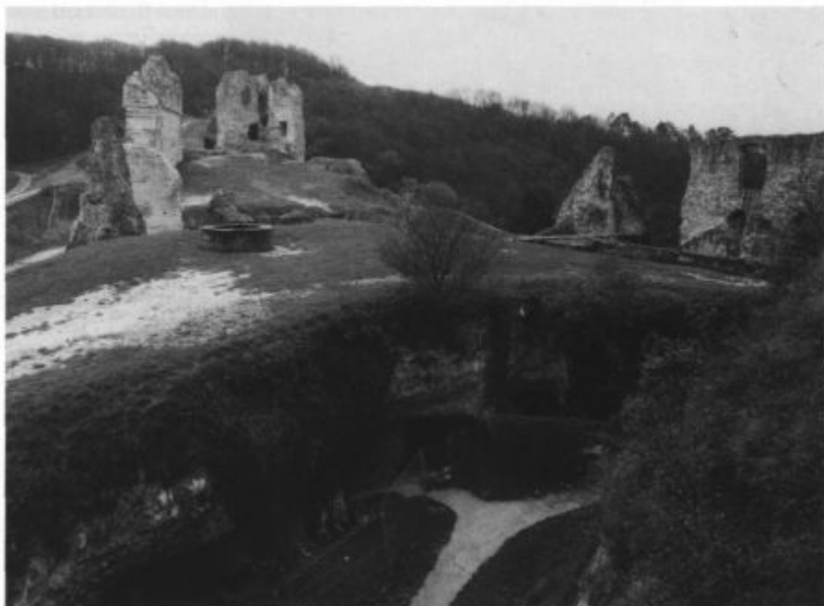
Figure 4: l'ouvrage avancé et la première enceinte; à l'arrière plan le fossé autour de la deuxième enceinte.
