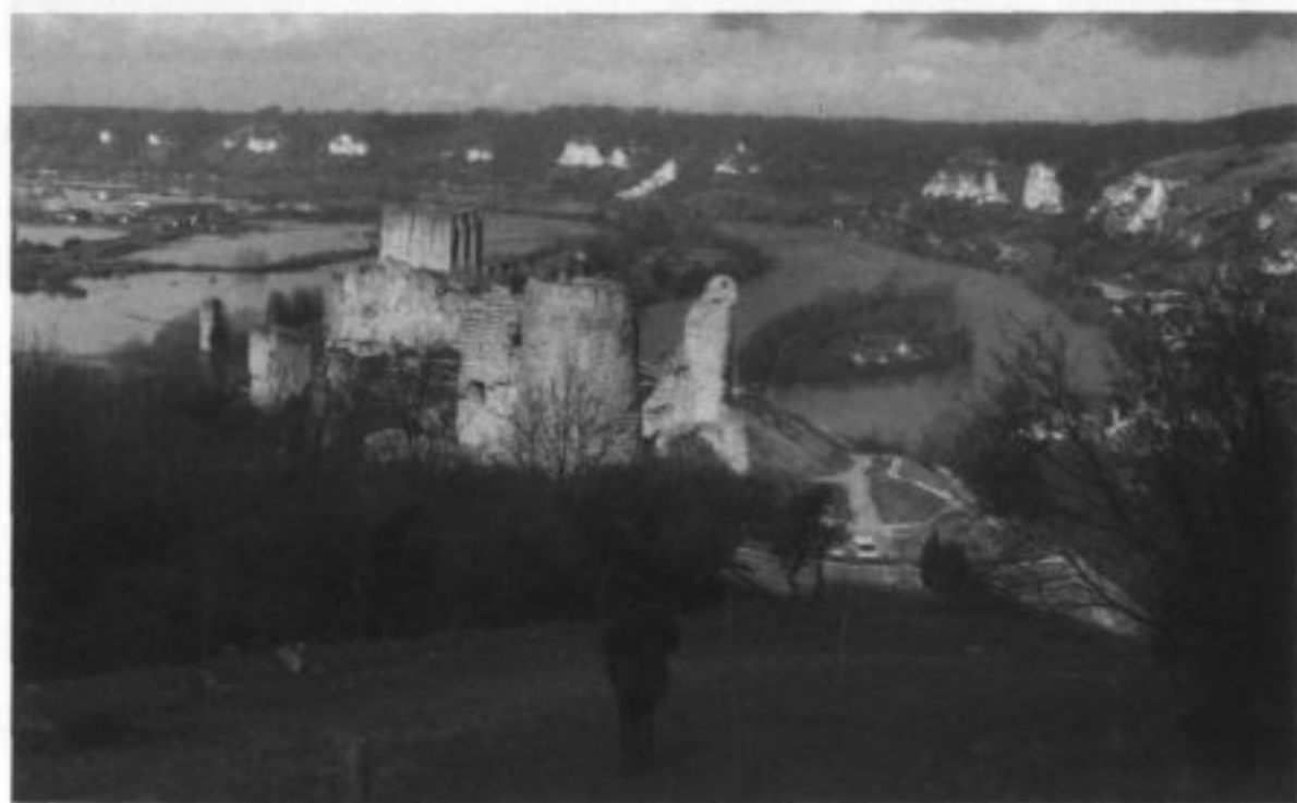
Figure 2: vue du côté sud.
