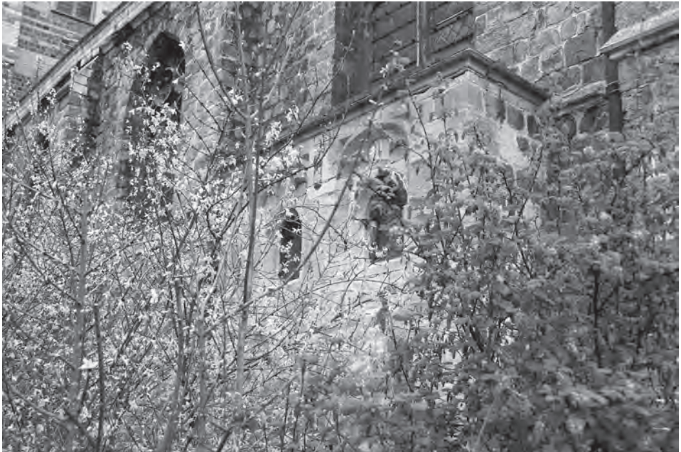
Figure 4: Vue extérieure de la chapelle funéraire d'Hervé de Mériadec et de Jeanne de Croix. L'enfeu n'est pas encastré dans le mur de l'église, mais est en saillie. Les deux fenêtres (murées depuis) sont enrichies d'un encadrement trilobé. Il paraît peu probable que le toit ait toujours été plat: les combles pointus que l'on attend peuvent avoir disparus en même temps que l'arcature intérieure du monument. Si effectivement les vitraux ( infra , fig. 14) sont antérieurs à la fondation d'Hervé de Mériadec, le gros œuvre de la chapelle doit l'être aussi, sauf déplacement des vitraux ou fondation rétrospective (Cliché Sébastien Hamel/Franck Viltart, 23 mars 2007).
