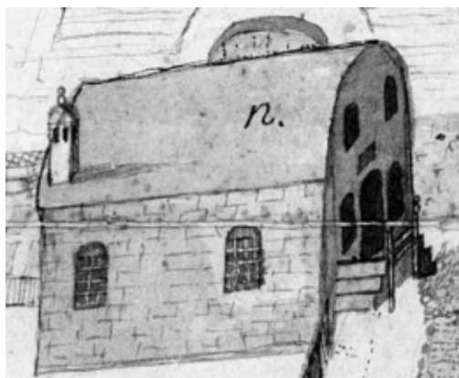
Abb. 1: Auf Anweisung Bonnacs errichtetes freistehendes Kanzleigebäude der französischen Botschaft in Istanbul 72
