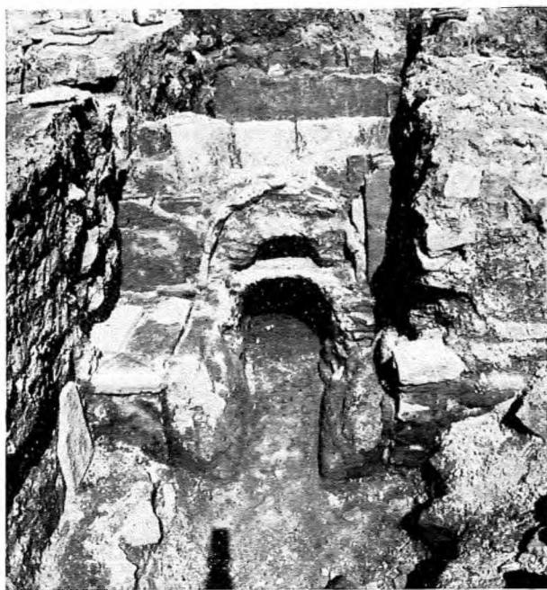
Abb. 4: Die Feuerung vor dem Warmbaderaum, darüber das Becken mit der Bogenöffnung.
