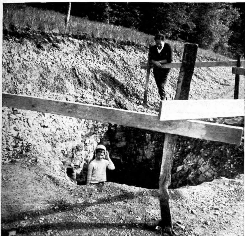
Abb. 1: Alter Bergwerkstollen in Wischeid, aufgebrochen beim Bau eines Feldwirtschaftsweges
