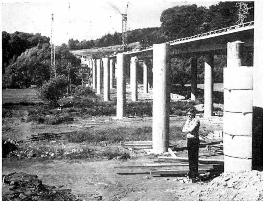
Abb. 5: Die Autobahnstelle bei Wittlich 1973 (vgl. hierzu den Zustand von 1940 auf Abb. 3).
