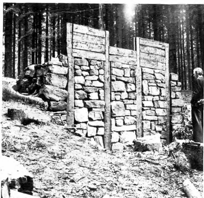
Abb. 7: Rekonstruierte Pfostenschlitzmauer einer vorgeschichtlichen Befestigung auf dem Burgring bei Prüm (Kr. BIT-PRÜ).
