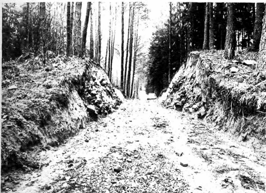
Abb. 23: Bei der Anlage eines Waldweges durchschnittener Abschnittswall des 1. Jahrhunderts v. Chr. „Auf Soels“ bei Trier-Ehrang. Im Profil sind die Reste einer komplizierten Mauerkonstruktion sichtbar.
