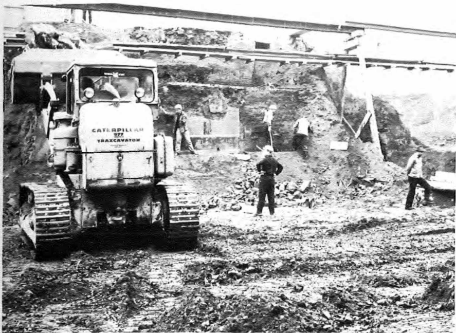
Abb. 21: Das Foto verdeutlicht unter welchen Bedingungen der Archäologe, wie hier am Konstantinplatz in Trier, bisweilen zu arbeiten hat. Größere Baugeräte beseitigen „problemlos“ ganze Mauerzüge. Nicht immer ist, wie in diesem Falle bei den Ausschachtungsarbeiten für eine Tiefgarage, die Möglichkeit für archäologische Untersuchungen gegeben. Die durch die Bauarbeiten bedrohten Wandmalereien eines größeren Privathauses konnten hier jedoch rechtzeitig geborgen werden und sind heute im Rheinischen Landesmuseum der Öffentlichkeit zugänglich gemacht.
