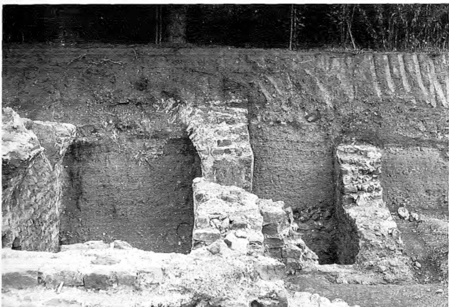
Abb. 3 Blick auf den Keller nach Norden.
