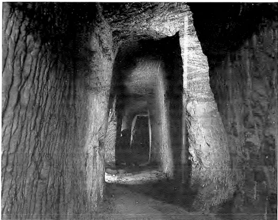
Abb. 2 Blick in den Hauptstollen hinter der Verteilerkammer.
