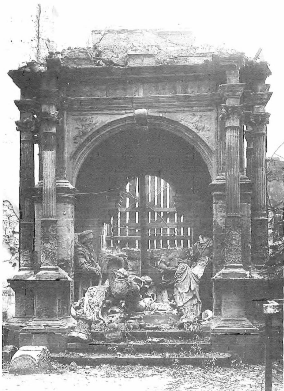
Abb. 7 Zustand des Heilig-Grab-Denkmal im Landesmuseum vor dem Abbau 1948.
