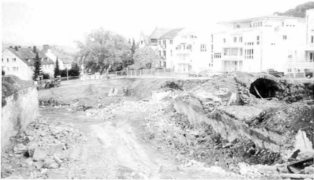
Abb. 3 Die Baugrube von Bauabschnitt III westlich der Bergstraße nach dem Abbruch der ehemaligen Brauereikeller.
