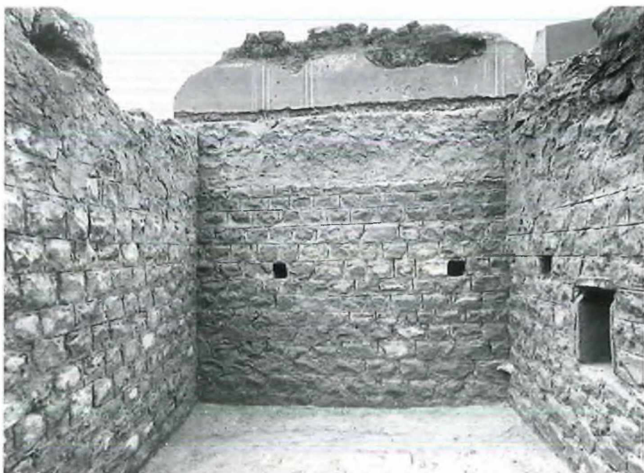
Abb. 4 Keller 1, Blick von Westen. In der Mitte drei Gerüstlöcher, rechts rechteckige Nische; über der Kellermauerkrone bemalter Wandverputz einer späteren Phase.
