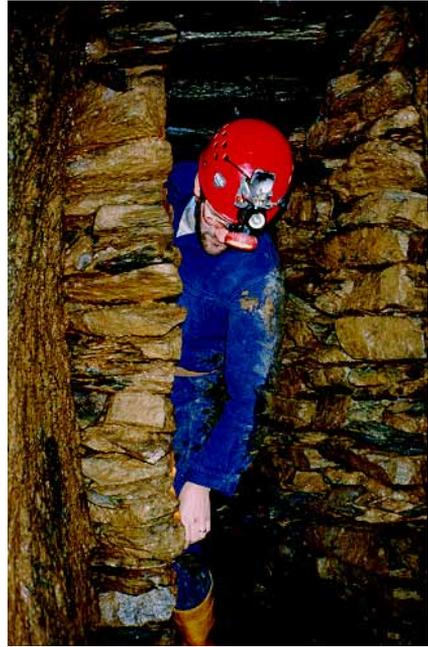
Abb. 13 Schacht 6 ist mit seitlichen Schiefertrockenmauern und aufliegenden großen Schieferplatten gesichert. Die Durchgangsbreite beträgt hier etwa 0,20 m. Blick nach Süden.
