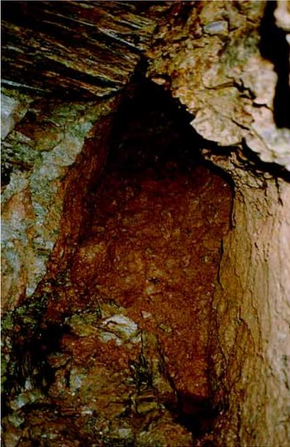
Abb. 16 Derzeitiges Ende des Qanats in Baulos U. Der Qanat ist hier von Lehm und Schiefersteinen verschlossen. Blick nach Norden.
