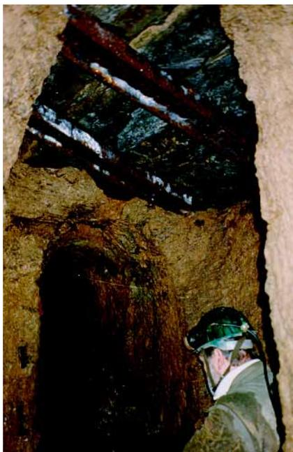
Abb. 10 Blick auf Schacht 4, der mit Eisenträgern und Schieferplatten 1901 gesichert wurde. Blick nach Süden.
