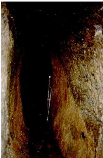
Abb. 15 Blick nach Süden auf Schacht 9. Im Vordergrund ist der Abdruck des Schuttkegels vom Einbruch der Schachtverfüllung zu erkennen. 1901 wurden diese Erdmassen ausgeräumt.
