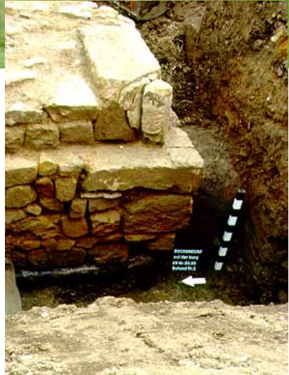
Abb. 9 Detailansicht der Süd-West-Ecke der Turmburg mit Buchenpfahlrost.
