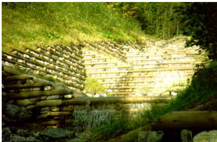
Abb. 8 Wildwasserverbau nach Art der Krainger Wand in den Alpen (Bregenzerwald 1999).
