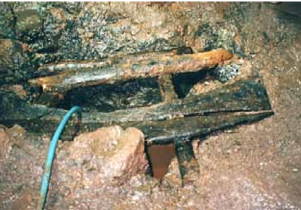
Abb. 5 Schachtverbau im Weitungsbereich des Bergwerks „Bierfincksgraben“.
