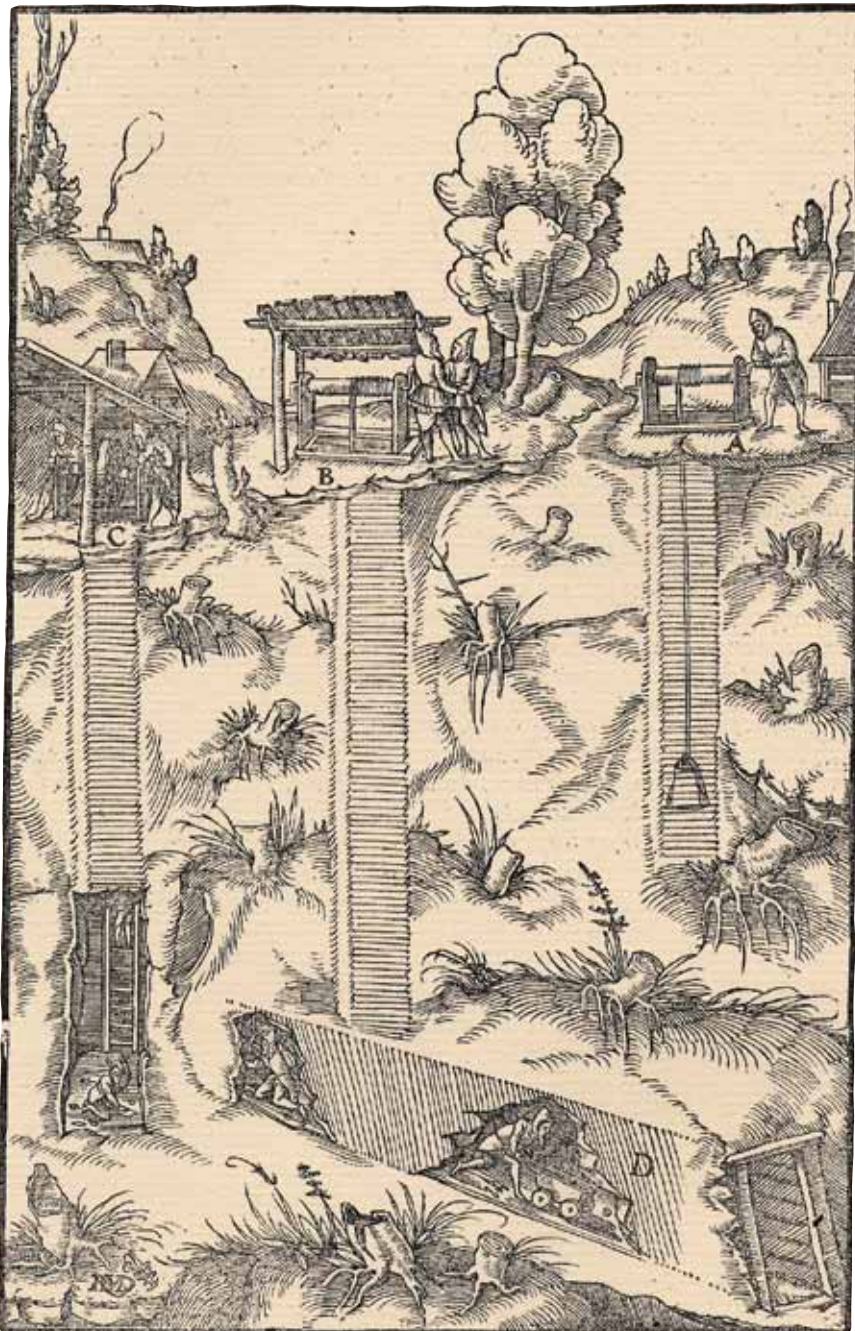
Abb. 1 Nach Agricola, Fünftes Buch: „Drei saigere Schächte. Der erste Schacht, der noch nicht bis zum Stollen geteuft ist A. Der zweite Schacht, der den Stollen erreicht hat B. Der dritte Schacht, bis zu dem der Stollen noch nicht vorgetrieben ist C. Der Stollen D.“.
