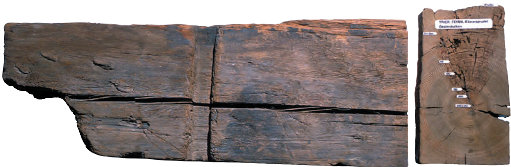
Abb. 3 Trier, „Römersprudel“. Gesimsbalken aus Tannenholz, 81 n. Chr.
