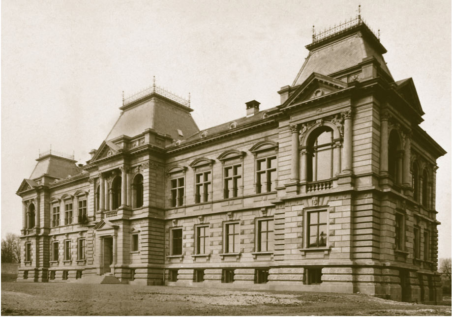
Abb. 2 Trier, Museum. Zustand nach der Fertigstellung, 1889.
